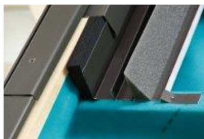
Przekrój kołnierza z materiałem docieplającym
